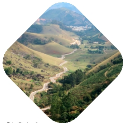
Foto: Divulgação A obra de implantação e pavimentação da Rodovia Castelo x Muniz Freire foi inaugurada em julho
