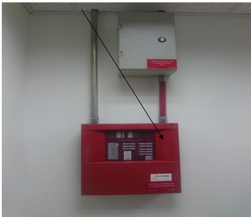
Central de Alarme e Combate a Incêndio
