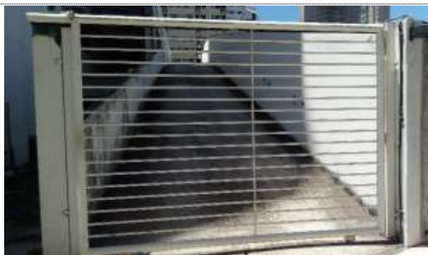
Imagem 03: Portão de acesso dos funcionários.
