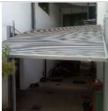
Imagem 04: Portão de acesso carga/descarga (interno).
