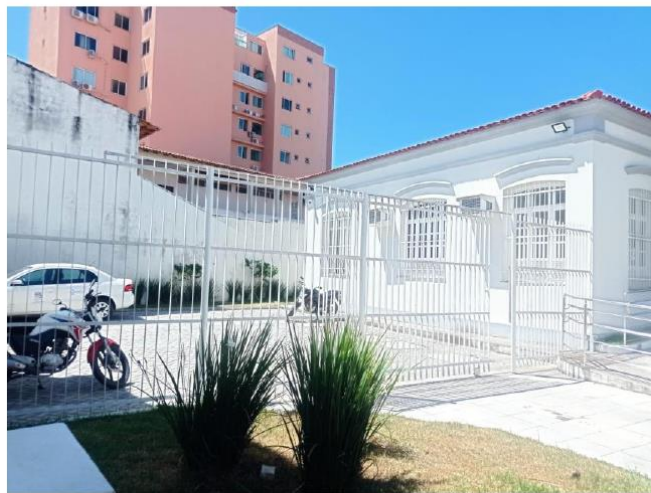
Portão Automático Estacionamento 01 – Parte Externa
