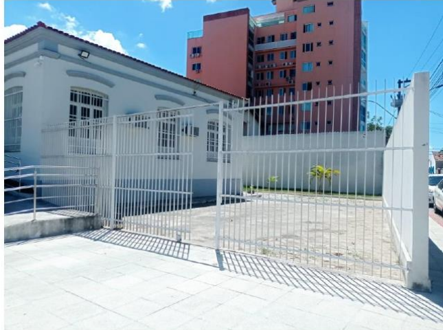
Portão Automático Estacionamento 02 – Parte Externa
