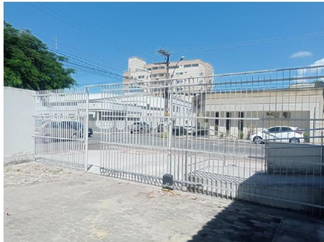
Portão Automático Estacionamento 02 – Parte Interna
